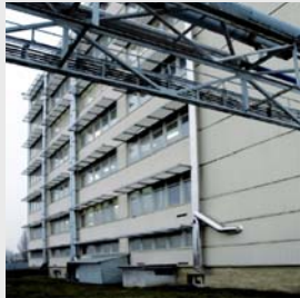
Partnerwerk in Litovel
